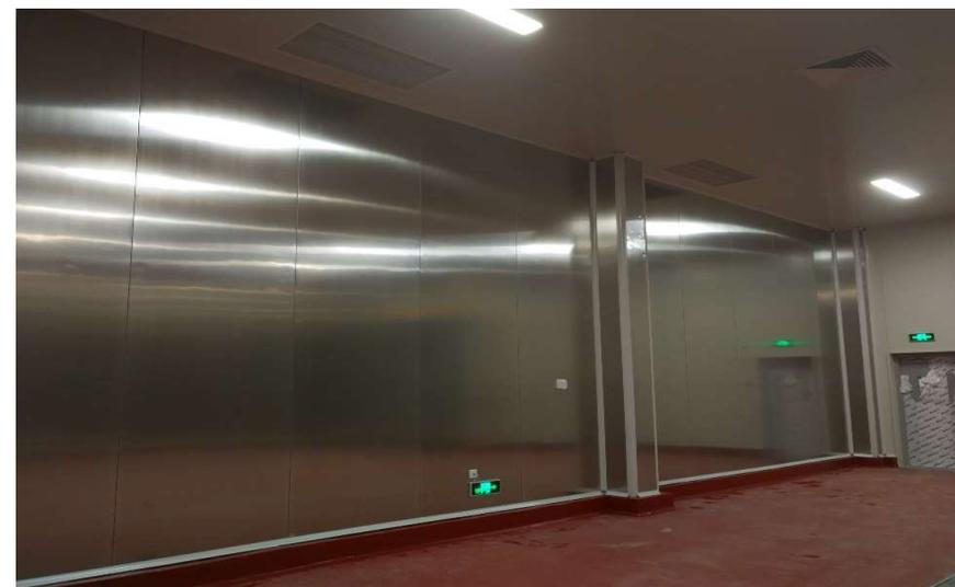
彩钢板材料的选择过程中，主要影响材料使用寿命的，除了彩钢板基材外还有材料本身的涂层、镀层、钢种的影响以及使用方法的影响。对涂层的选择要考虑的要素很多，它主要包括涂层种类、涂层厚度、涂层颜色和涂层光泽度。另外，有时候还要考虑涂层的底漆和背面涂层的要求。目前用于彩色涂层钢板的涂料种类有**聚酯涂层 (PE)**、**聚偏氟乙烯层(PVDF)**、硅改性涂层 (SMP)、高耐候涂层 (HDP)、丙烯酸涂层、聚氨脂涂层(PU)、塑料溶胶涂层 (PVC) 等。
